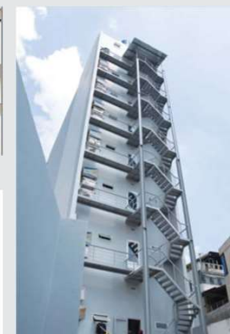
CẦU THANG THOÁT HIỂM ESCAPE STAIRCASE
