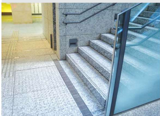
HỆ THỐNG MƯƠNG GUTTER SYSTEM
