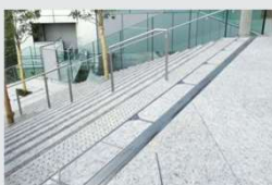
HỆ THỐNG MƯƠNG GUTTER SYSTEM
