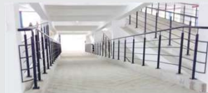
LAN CÀN KHU ĐỂ XE HANDRAIL PARKING AREA
